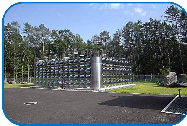
《 一本木浄水場の配水池 》
